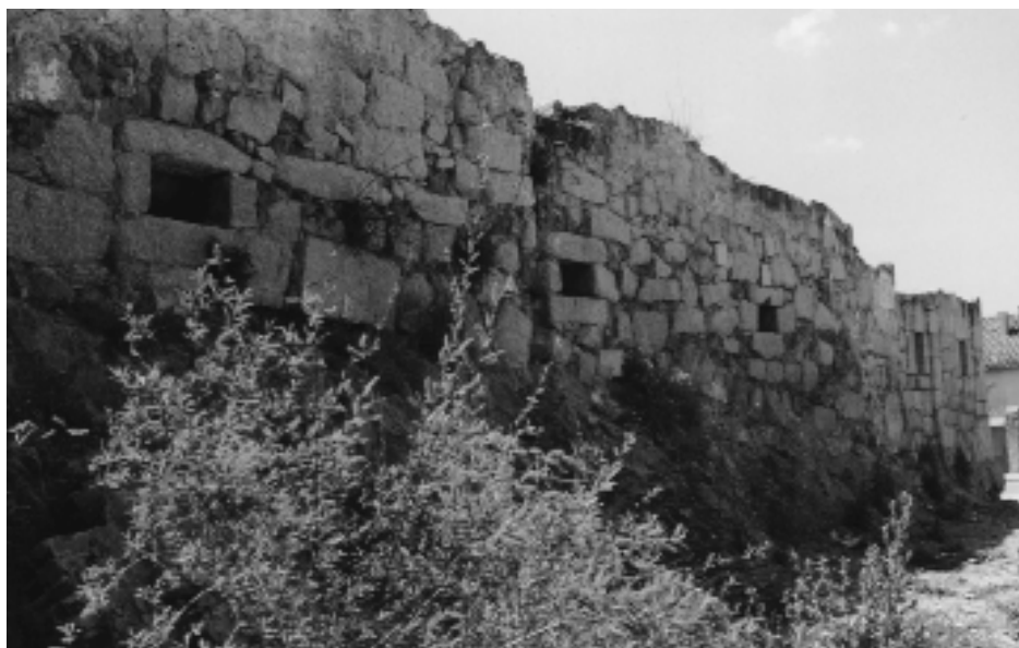
Muro lateral de la fábrica de Valdemorillo.
